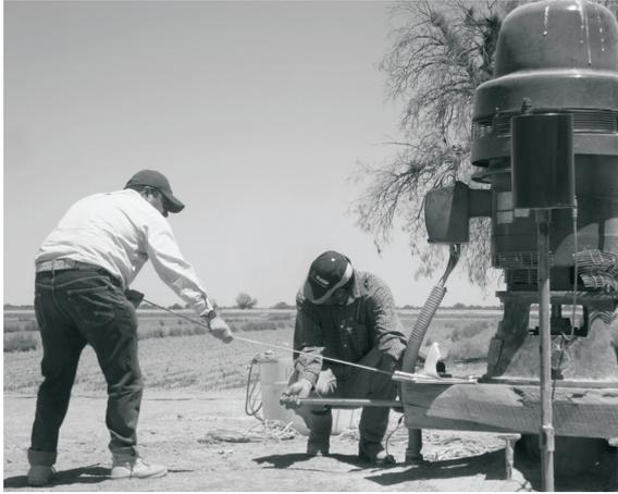
Figura 34. Determinación del nivel dinámico de un pozo mediante el sondeo.
